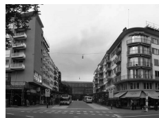
Ansicht des Bahnhofgebäudes.
